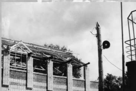
Строительство столовой, 1987 г.
